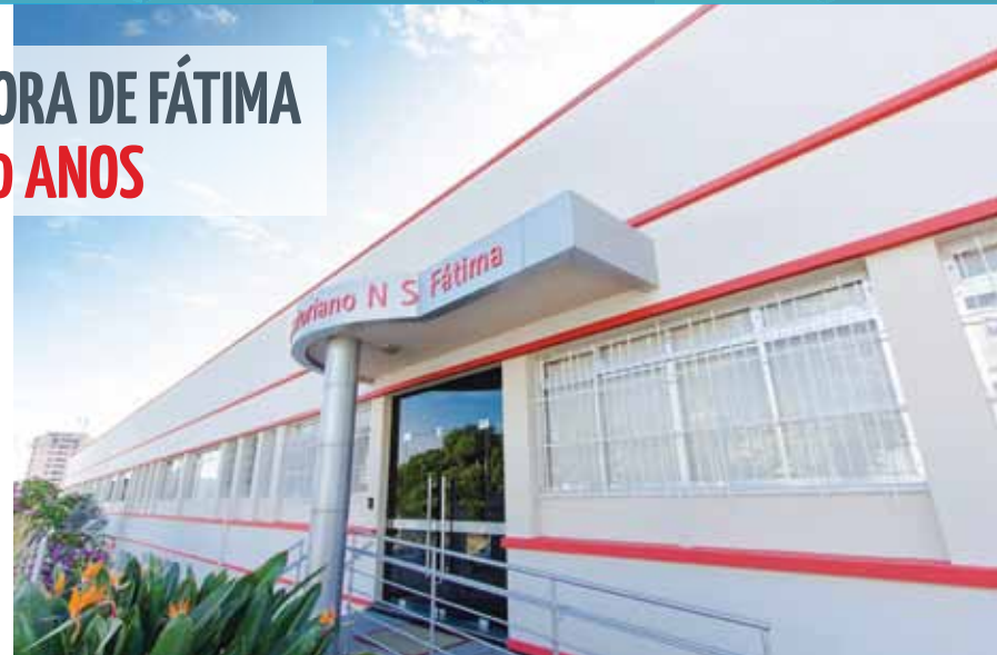
Instalações contemporâneas e compromisso social
